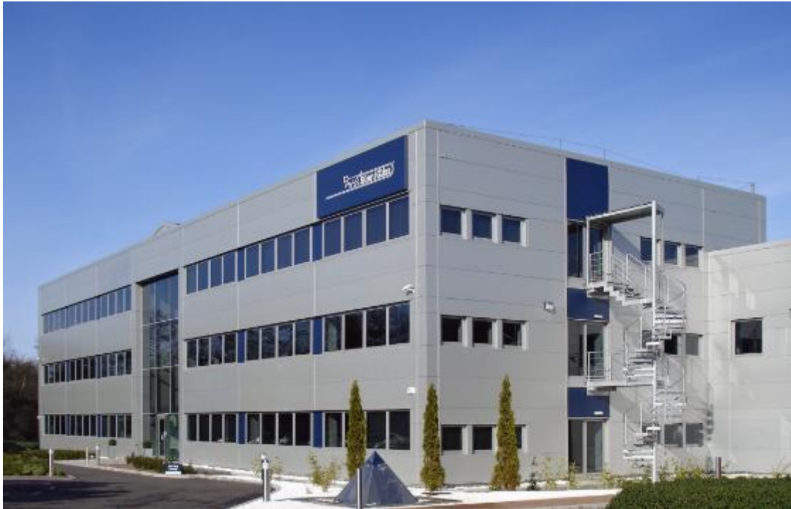
Slient Gliss倉庫プロジェクト 製品：横置きポリウレタン壁パネル
