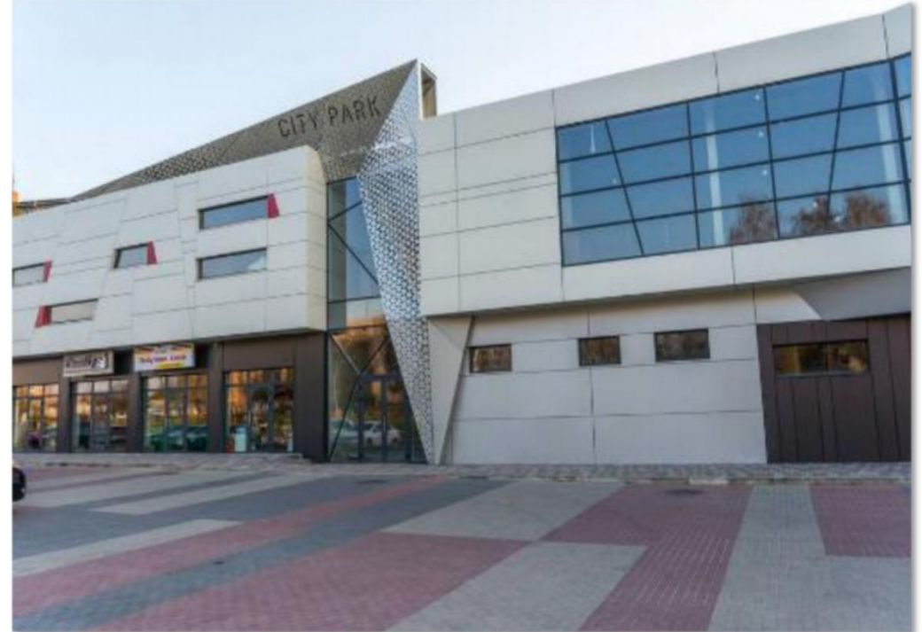
モルディブQuick Ezy Maldives PVT LTD都市公園プロジェクト 製品：アルミニウム単板、パンチングアルミニウム単板
