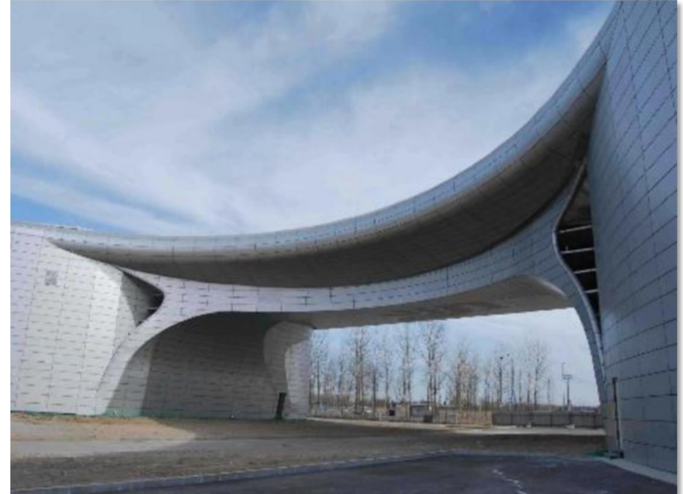
スーダン・ハルツーム政府発電所屋外 展示館の造形 製品：建築シングル室外アルミ単板
