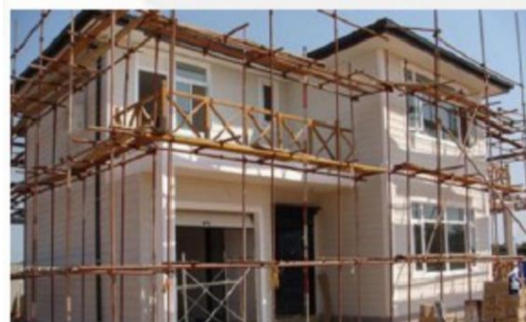
屋根工事と 防水工事
