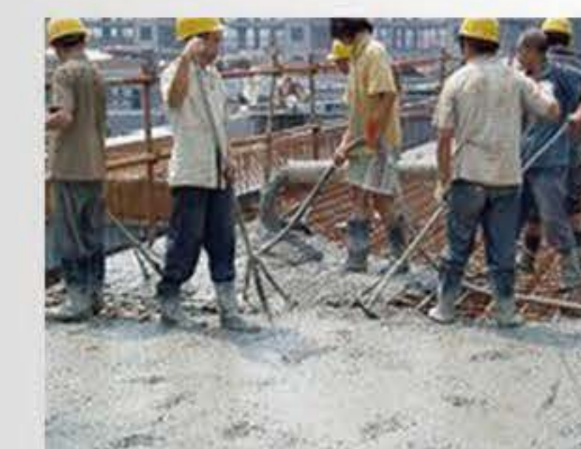
11. コンクリート打設 Placing concrete
