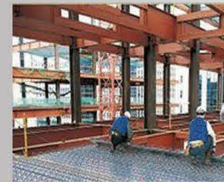
4. 現場敷設 Install on site
