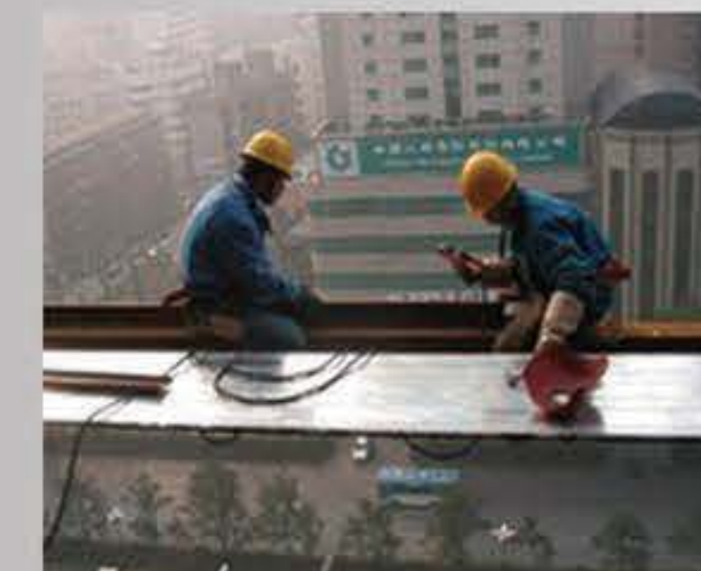
7. エッジテンプレートのインストール Install side templates
