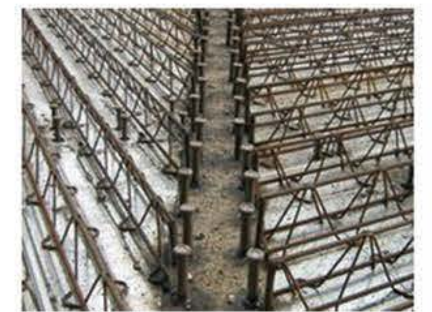
6. ボルト溶接 Weld bolts
