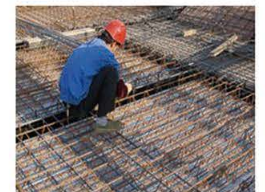
9. 現場での追加の鋼製ラッシング Binding the extra rebar on site
