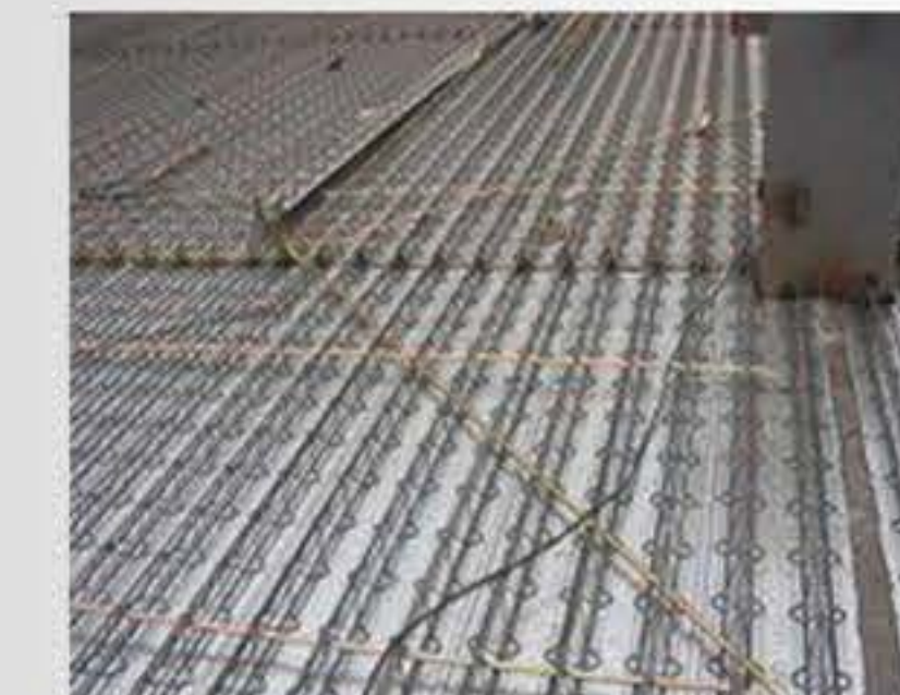
8. 現場パイプライン敷設 Lay out the pipe on site
