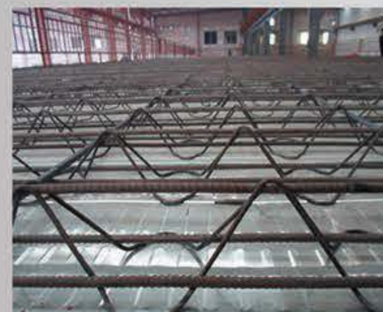
10. 敷設完了 Binding finish
