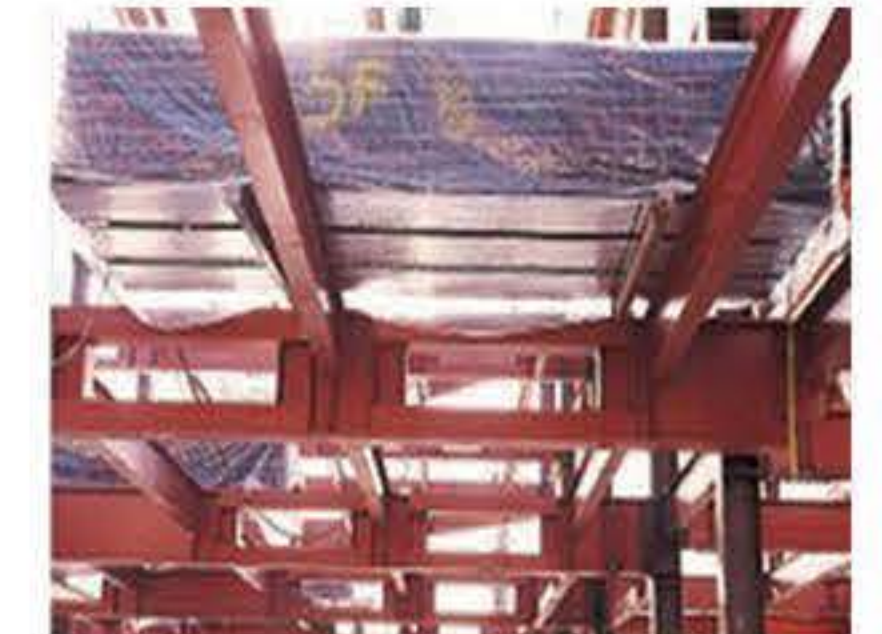
3. 現場でのスタッキング Stack on site
